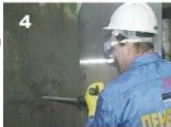
По всей длине трещин, швов, стыков, сопряжений, примыканий и вокруг ввода коммуникаций выполнить штрабы П-образной конфигурации сечением не менее 25x25 мм. Штрабы очистить щеткой с металлическим ворсом. Удалить рыхлый слой бетона (при наличии такового).
